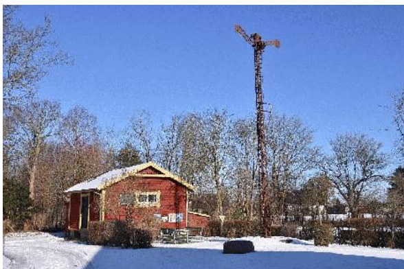
Flintinge i km 34,1 på SNNB med pakhus og signal, fredag 12. februar 2021 .
